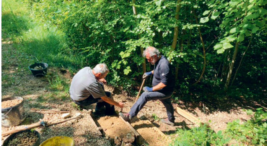
■ Wegbau im Juni, wo wir an diversen Stellen neue Treppenstufen einbauten.
