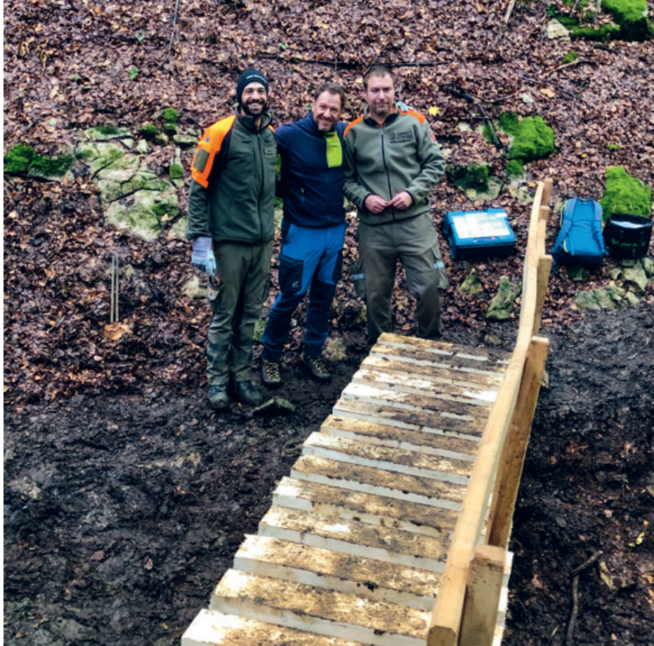
■ Wegsanierung Risimatt, Weissenstein.
