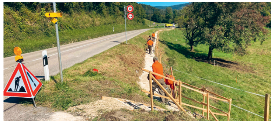
■ Verlegen des Wanderweges Nuglar-Orismühle in Richtung St. Pantaleon.
